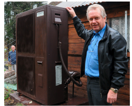
Harry Battaglia von der Viessmann (Schweiz) AG mit der Ausseneinheit, die vor das Holz-Gartenhäuschen platziert wurde. Der Eigentümer verpasste ihr einen braunen Anstrich, sodass das Gerät aus Distanz kaum auffällt.
