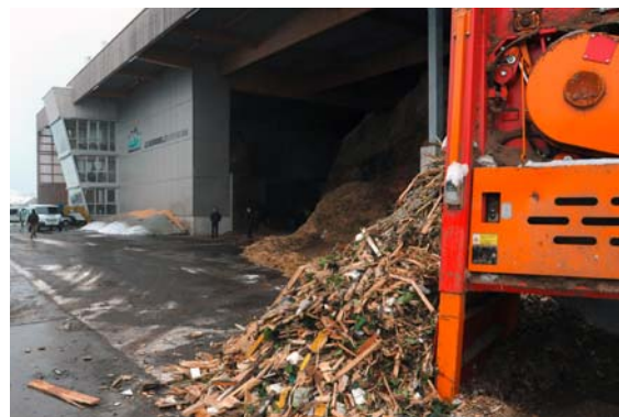
Das Energiezentrum Wintersried mit einer Gesamtleistung von 10,4 MW beliefert zurzeit 130 Wärmebezügler.
