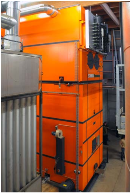
9,0 Meter lang, 3,2 Meter breit, 9,5 Meter hoch und 120 Tonnen schwer: die 6-MW-Vorschubrostfeuerung UTSR-6500.32 der Schmid AG.
